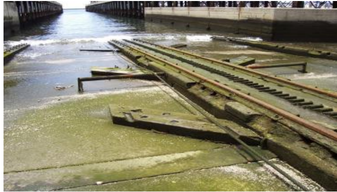
Gambar 2.2 Slipway Dock Sumber: Dimas, 2022 (dokumen pribadi)
